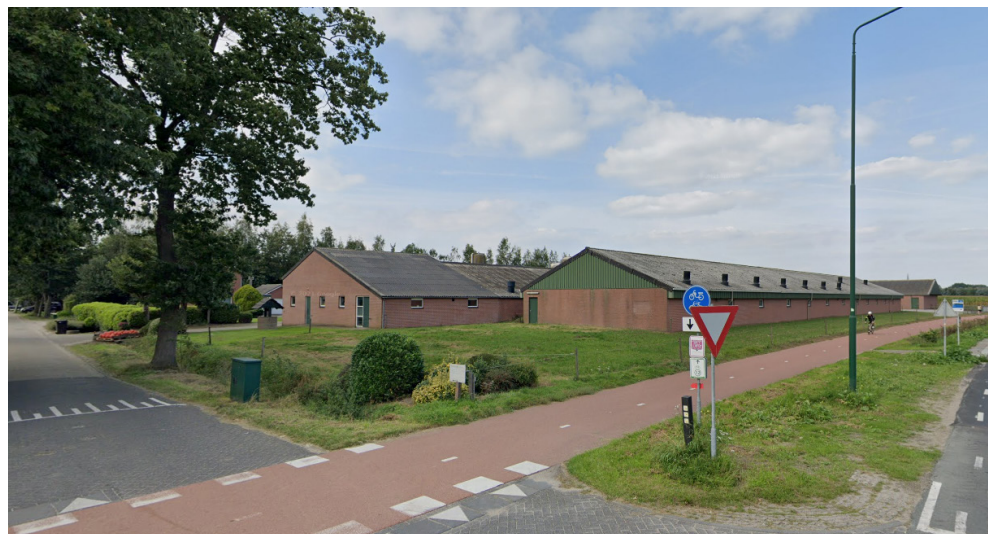
Zicht vanaf Baarleseweg op de te slopen schuren
