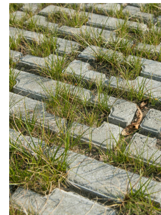
Open, grasklinkers van beton
